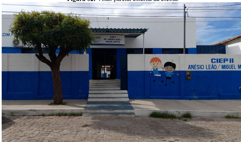
Figura 02: Visão parcial externa da escola.
