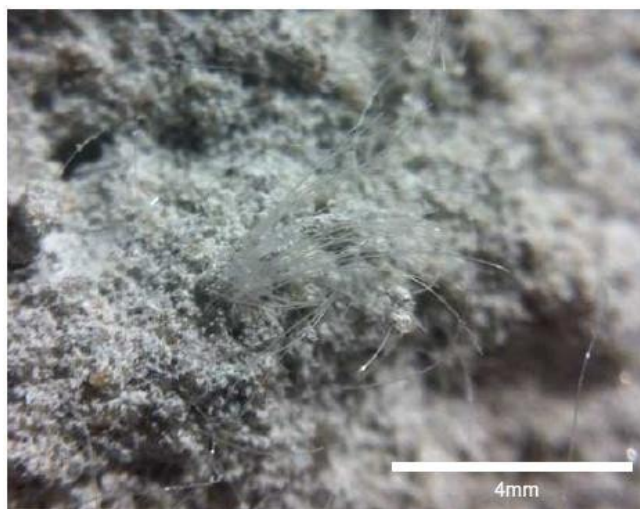
Figura 17 - Acúmulo de fibra no interior da argamassa
