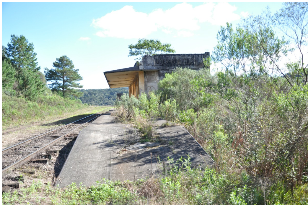
Figura 3 – Imagem tomada em 2019: outra perspectiva da Estação Ferroviária abandonada
